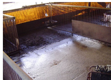
▲ 슬랏과 콘크리트 바닥으로 구분된 돼지 방. 슬랏 부분을 제외한 휴식 공간은 그 안에 사육되는 돼지의 수에 비해 매우 좁다.
